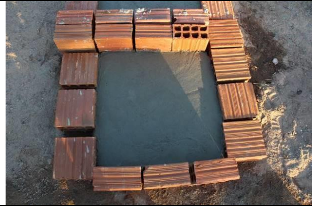
Figura 6: Laje quadrada que servirá de tampa para caixa de gordura (direita)
