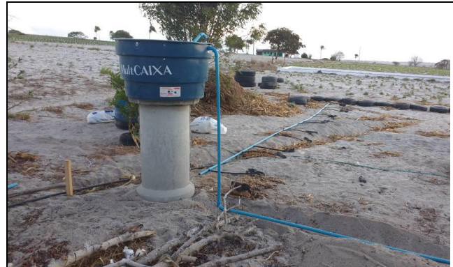
Figura 42: Caixa d'água do Sistema de Bioágua sob manilha. Ao fundo, linha principal de irrigação de onde saem as fitas de gotejamento do sistema de irrigação.
