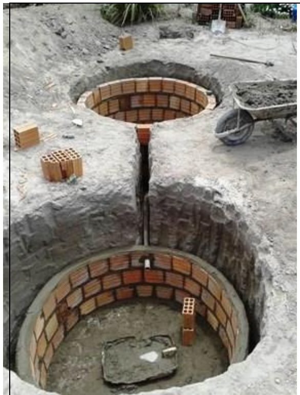
Figura 16: Execução e alvenaria circular dos tanques (filtro biológico e tanque de reuso)
