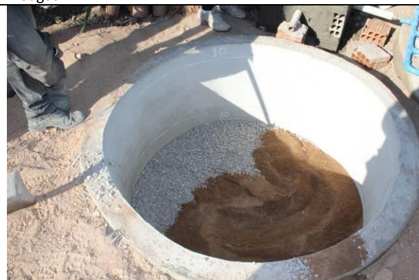
Figura 26: Camada de 10cm de areia lavada do filtro biológico do Bioágua
