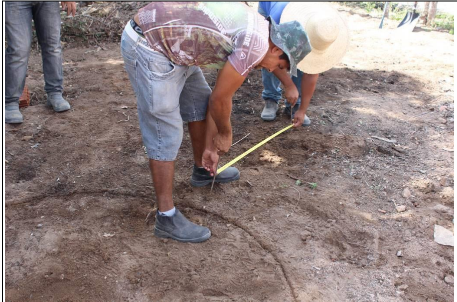
Figura 1: Locação dos pontos de escavação dos tanques do Sistema – execução da circunferência utilizando o compasso de obra.
