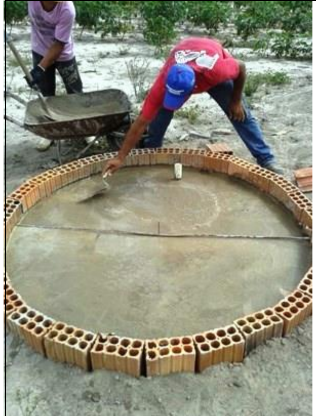
Figura 4: Exemplo de forma para laje de tampa do tanque de reuso do sistema.
