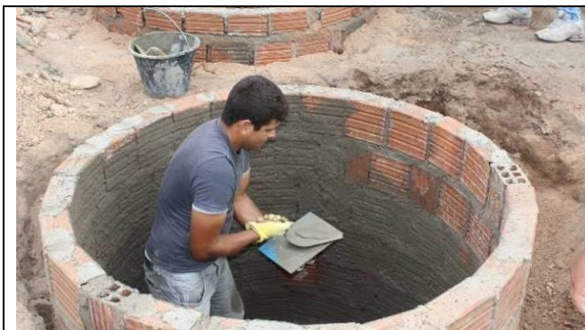
Figura 17: Execução do chapisco no tanque
