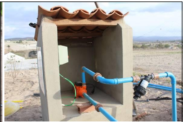
Figura 33: Casa de bomba acabada com chave magnética e bomba instaladas (direita).
