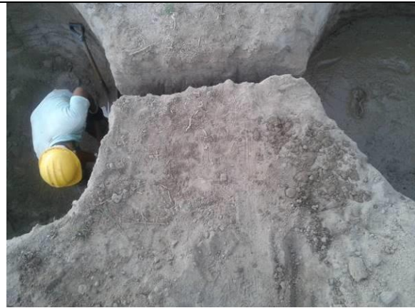
Figura 15: Detalhe de escavação entre os tanques para passagem de tubulação que liga o filtro biológico ao tanque de reuso.
