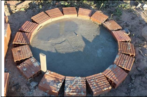
Figura 5: Laje circular que servirá de base para caixa d'água elevada
