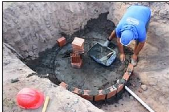
Figura 11: Detalhe de utilização do compasso de obra para marcação da circunferência da parede dos tanques
