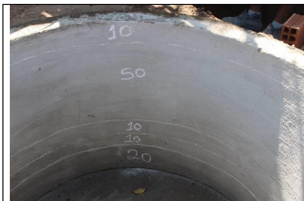
Figura 23: Marcação das camadas no filtro biológico do Bioágua
