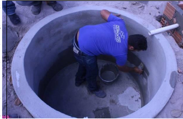
Figura 19: Aplicação de impermeabilizante hidrofugante – vedacit.
