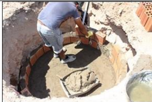
Figura 13: Elevação das fiadas de alvenaria
