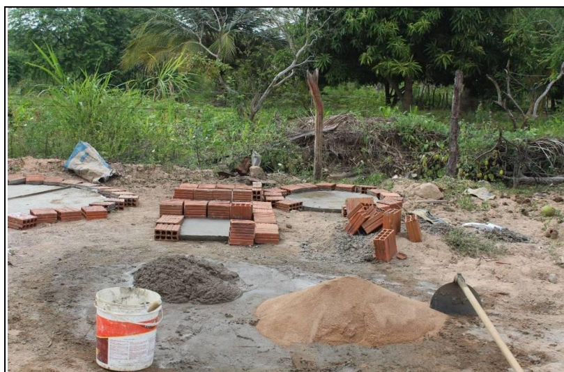
Figura 7: Local reservado no canteiro para produção de lajes e argamassas.
