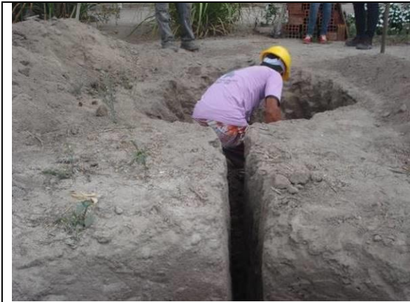
Figura 14: Espaço escavado entre os tanques biológico e de reuso.
