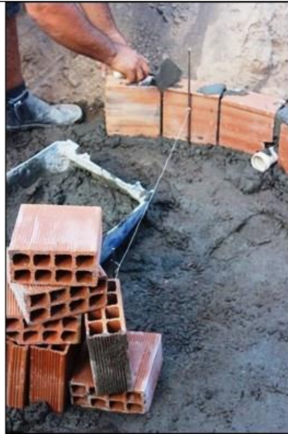
Figura 12: Utilização do prumo de face e execução da primeira fiada.
