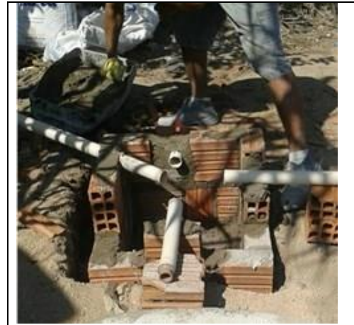
Figura 20: Execução da caixa de gordura elevada em alvenaria com tubulações de chegada e saída conectadas.
