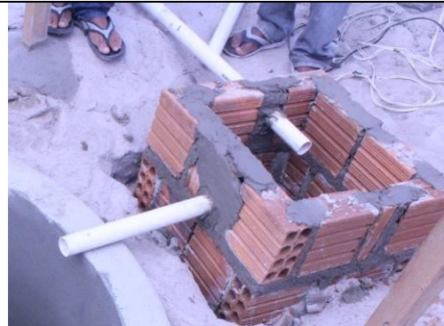
Figura 22: Alvenaria executada em tijolo com amarração. Caixa de gordura.
