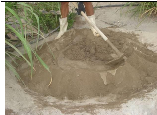
Figura 8: Execução de traço de concreto – mistura de cimento e areia
