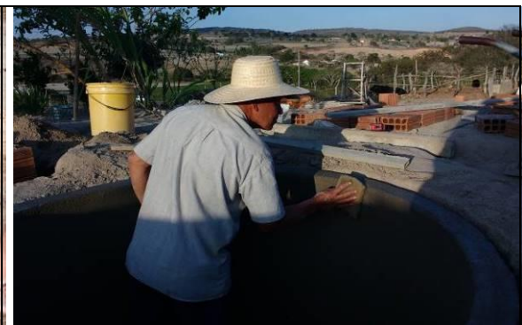
Figura 18: Acabamento final do reboco (feltragem com espuma de pedreiro).
