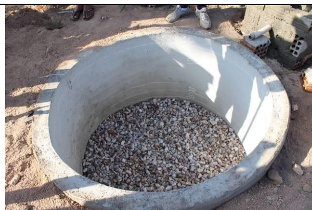
Figura 24: Camada de 20cm seixo do filtro biológico do Bioágua
