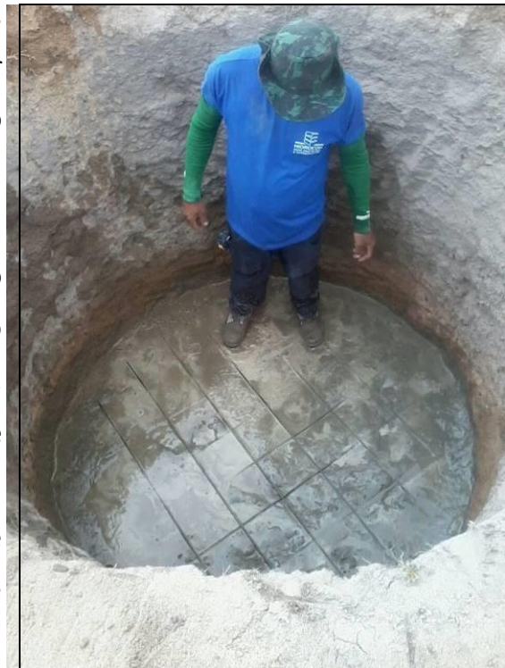
Figura 10: Execução da base dos tanques para posterior elevação de paredes.
