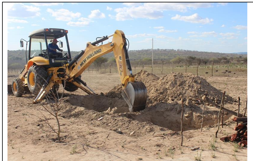
Figura 3: Escavação do sistema de Bioágua utilizando retroescavadeira em formato quadrado.
