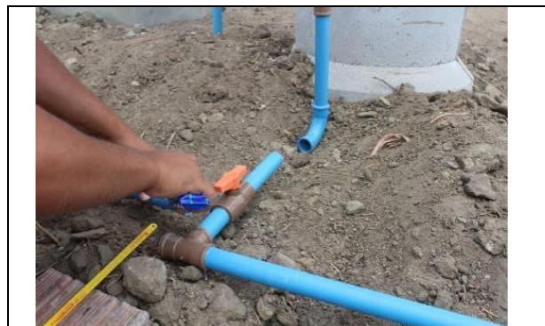
Figura 40: Detalhe da instalação hidráulica de saída da caixa d'água. Colocação do registro.
