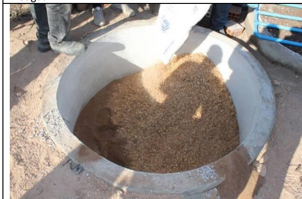
Figura 27: Camada de 50 cm de serragem do filtro biológico
